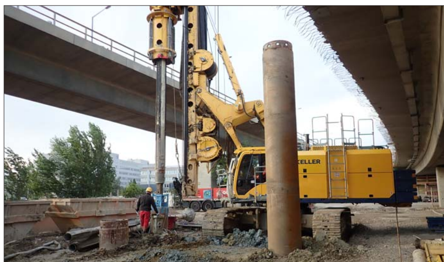
Bohrpfahlarbeiten im Bereich der Brückenverbreiterung
