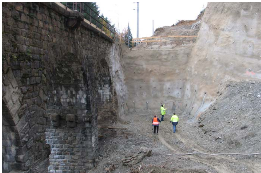
Baugrube Klinzergabenbrücke Blick Richtung Schwarzach
