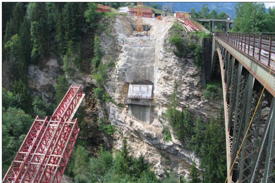
Angerschluchtbrücke Bestand und neu (im Bau); Blick auf Kämpferfundament Seite Schwarzach
