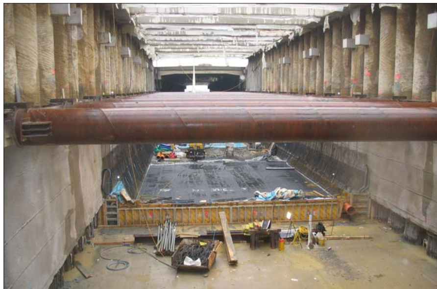
Offene Bauweise Hengsberg Süd (Abschnitt mit Gewölbequerschnitt): Herstellung der Sohlplatte im Schutze eines Bohrpfehlkastens mit temporärer Aussteifung
