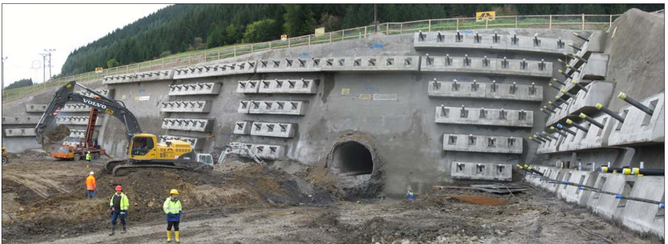
Ansicht Portalsicherung Višňové West
