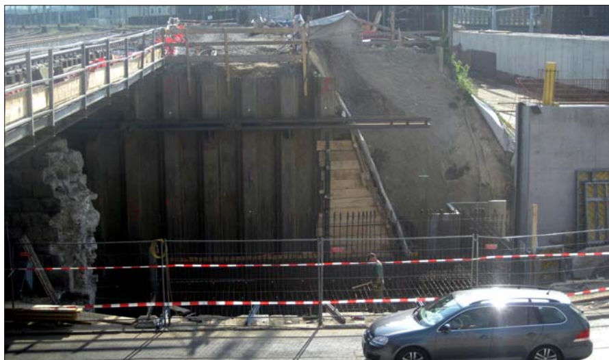
Eisenbahnbrücke über die Friedhofstraße, Baugrube für die Herstellung des Tragwerkes 3
