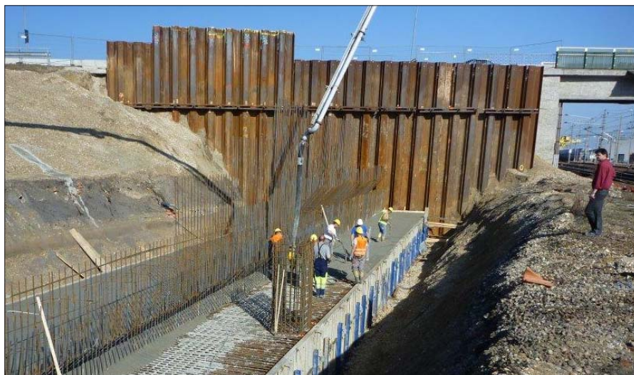
Spundwand Reichsbrücke, Widerlager Nord
