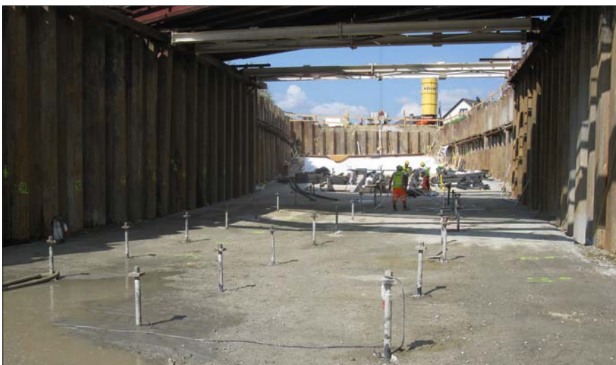
Baugrube nach Herstellung der Kleinbohrpfähle zur Auftriebssicherung
