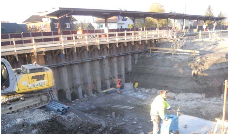
Blick in die Baugrube für die Fußgängerunterführung
