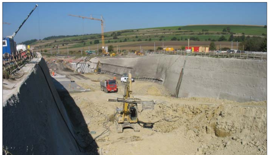
Construction Pit Tunnel Bründlkappelle
