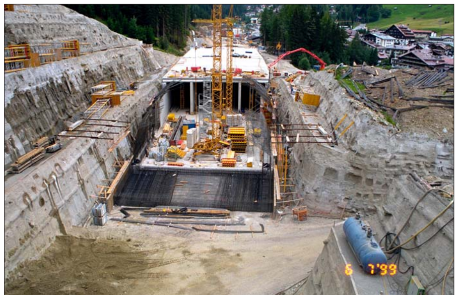
Offene Bauweise Wolfsgrubentunnel (Blick Richtung Westen)
