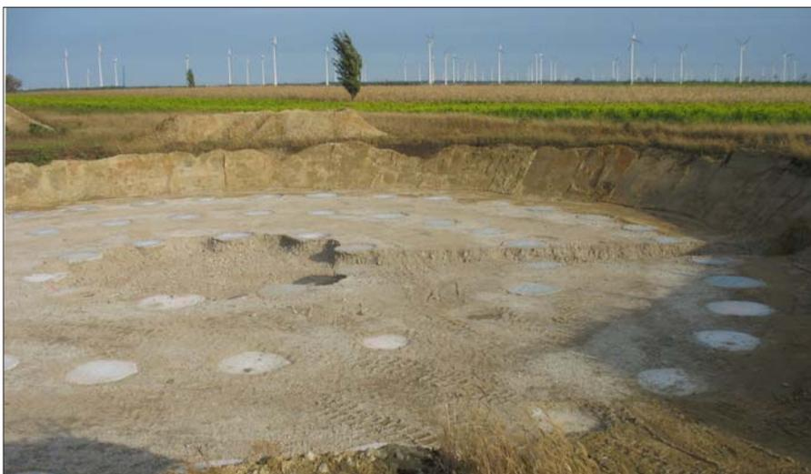
*Vorbereitete Fundamentsohle bei Bodenverbesserung mittels Betonrüttelsäulen*
