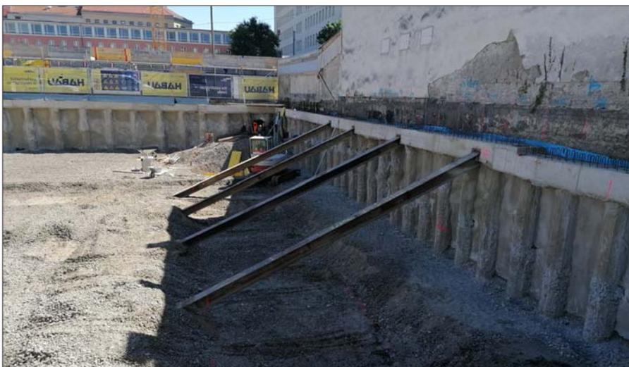
*Baugrubensicherung und Unterfangung Bestandsgebäude mittels aufgelösten Bohrpfehlwänden*
