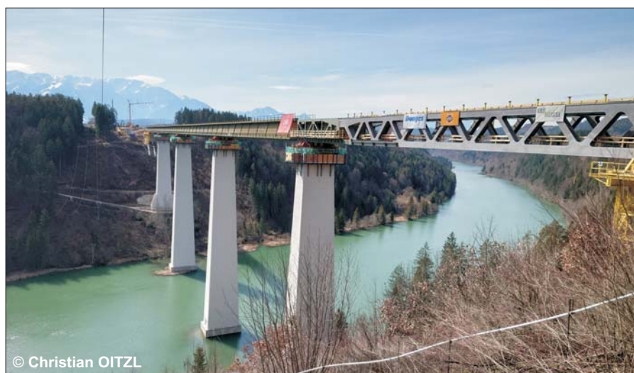
Einschub des Stahltragwerks (altes und neues Tragwerk sichtbar)
