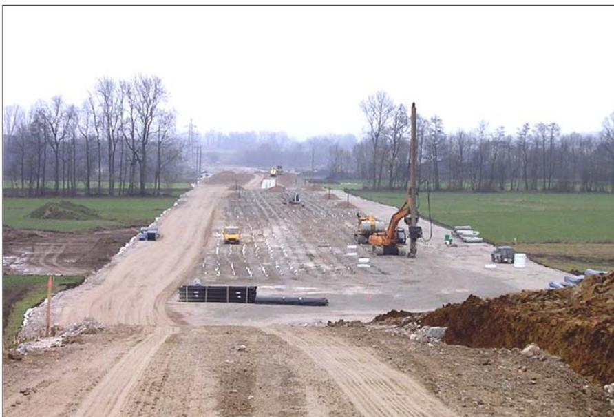
*Blick auf die vorbereitete Dammaufstandsfläche bei Herstellung der Vertikaldrains*
