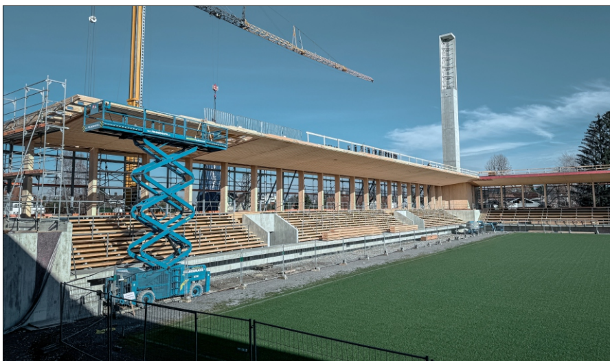
Herstellung Tribüne Ost (im Hintergrund Flutlicht-Turm Süd-Ost)
