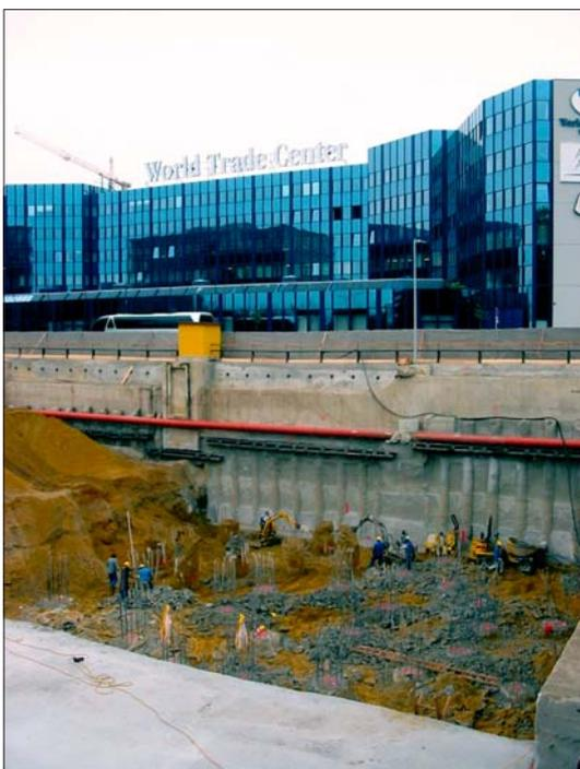
*Aushub bis UK Bodenplatte (Köpfe der kreisförmig angeordneten Bohrpfähle für die Towerfundierung sichtbar)*
