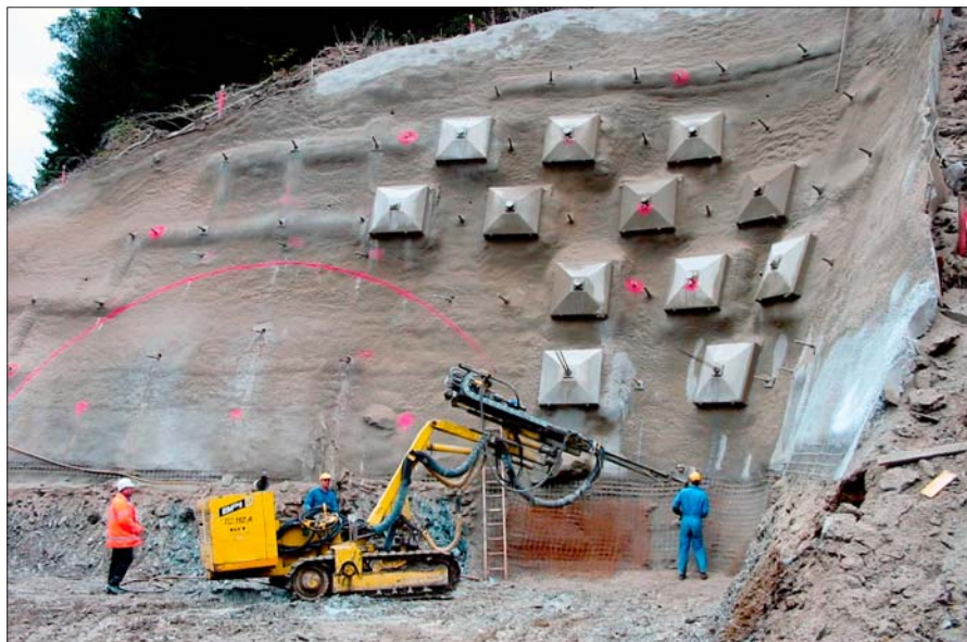
Westportal Unterwaldertunnel Anschlagwand
