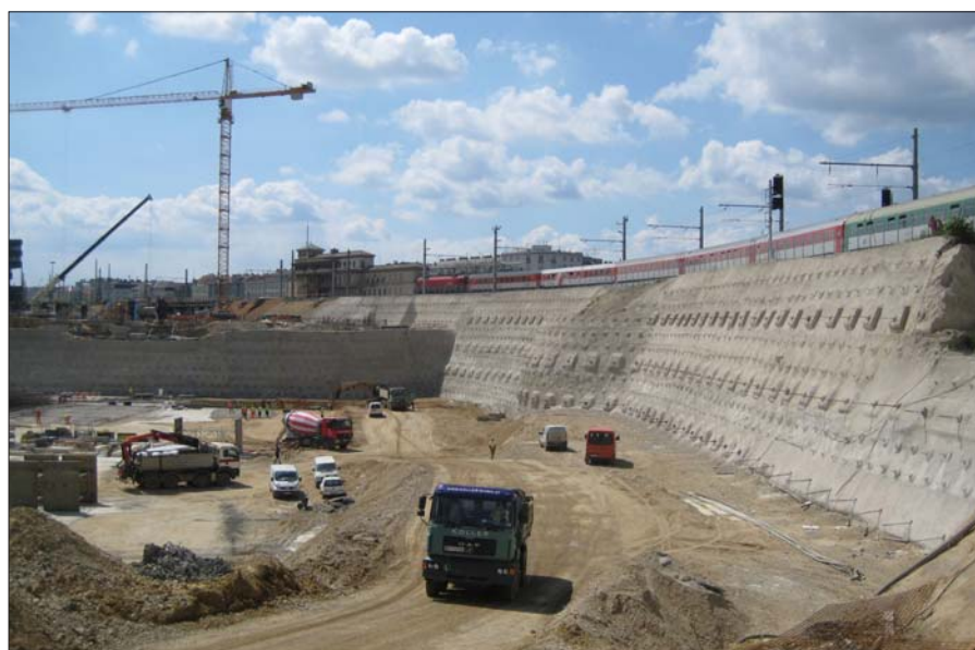
Blick in die Baugrube, Bahnhofskomplex Süd
