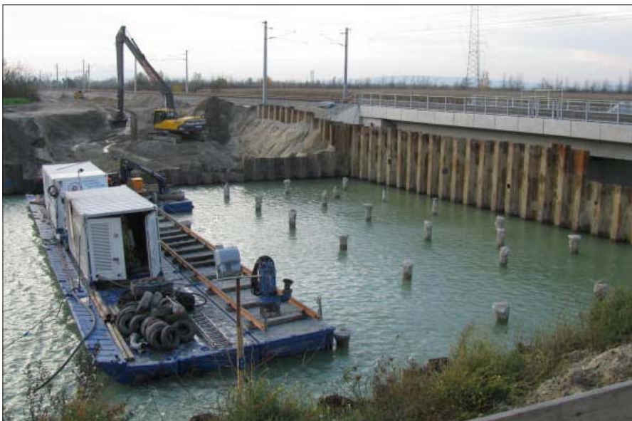
S1-Unterführung der Nordbahn, Herstellung der Unterwasserbetonsohle
