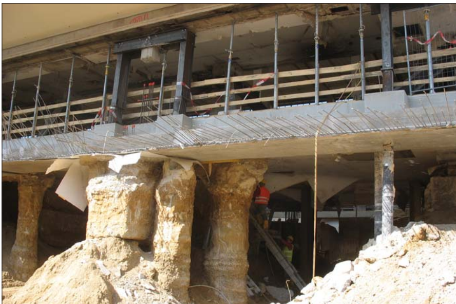
Herstellung Untergeschoss unter der Kassenhalle; temporäre Abfangung der Stützenlasten mittels DSV-Körper
