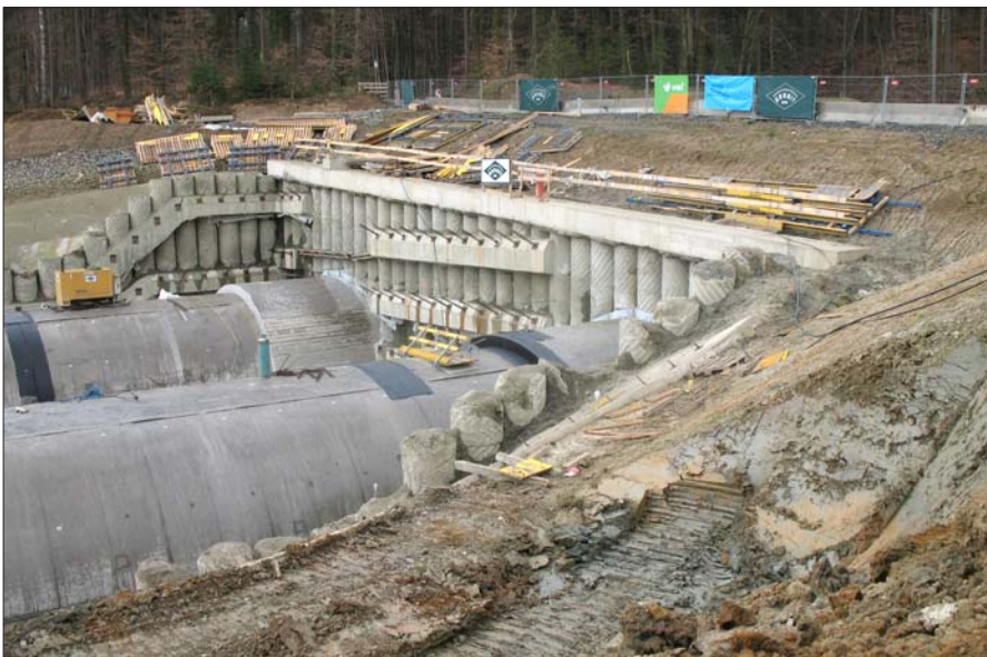
Blick auf das Ostportal Koralmtunnel (Anschlagwand der Geschlossenen Bauweise)
