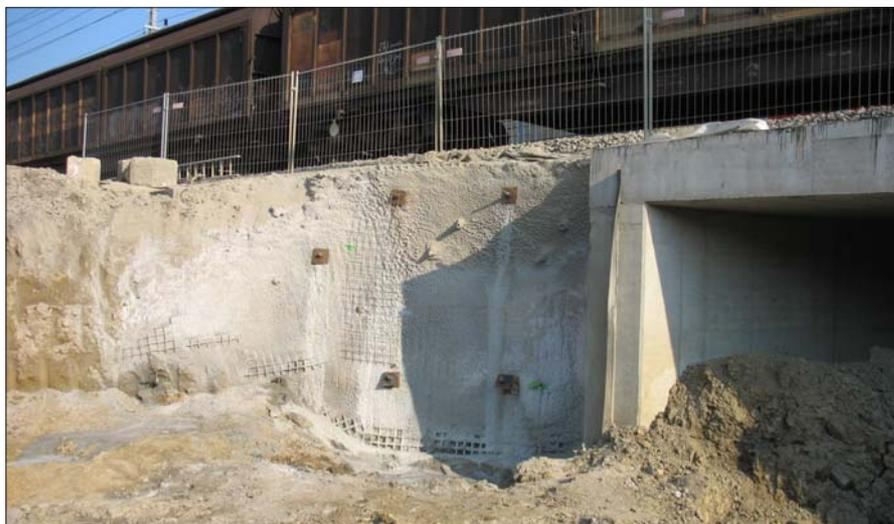
*Vernagelte Spritzbetonsicherung im Bereich der Unterführung Neilreichgasse*
