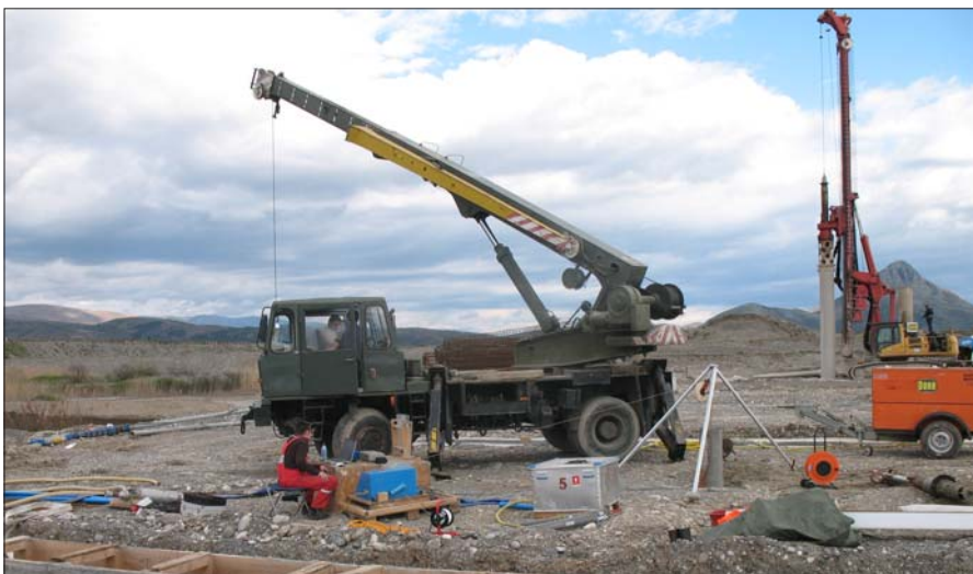
Herstellung Versuchsbrunnen, Überwachung hydraulische Versuche
