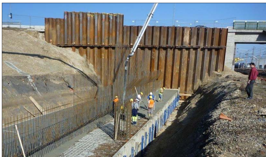
Spundwand Reichsbrücke, Widerlager Nord
