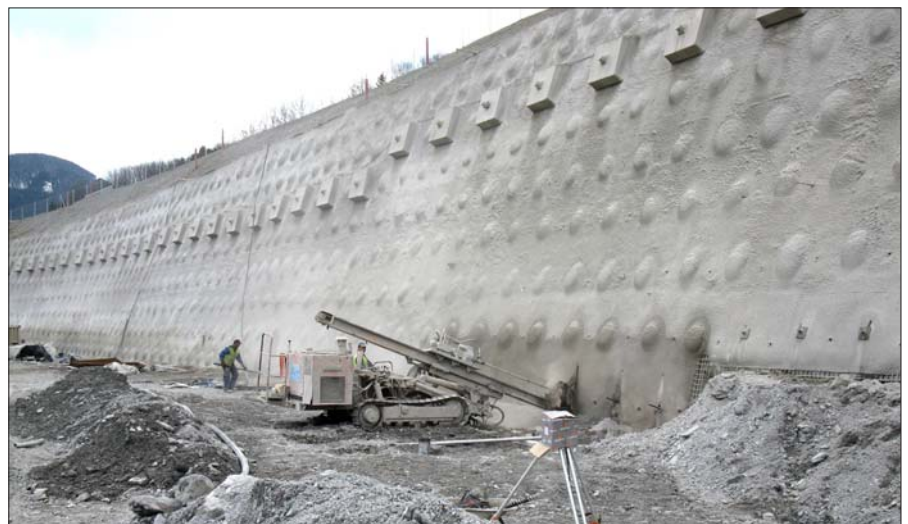
Böschungssicherung Portalbereich Gloggnitz
