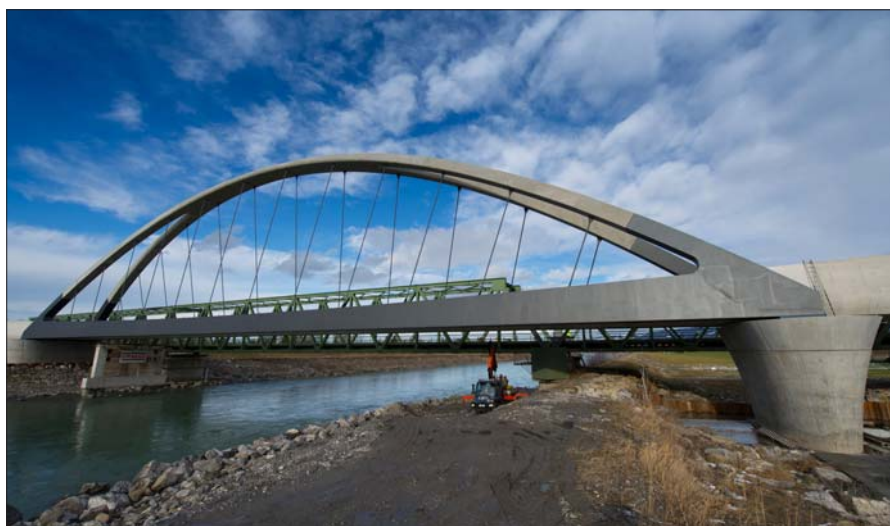
Rheinbrücke nach Fertigstellung
