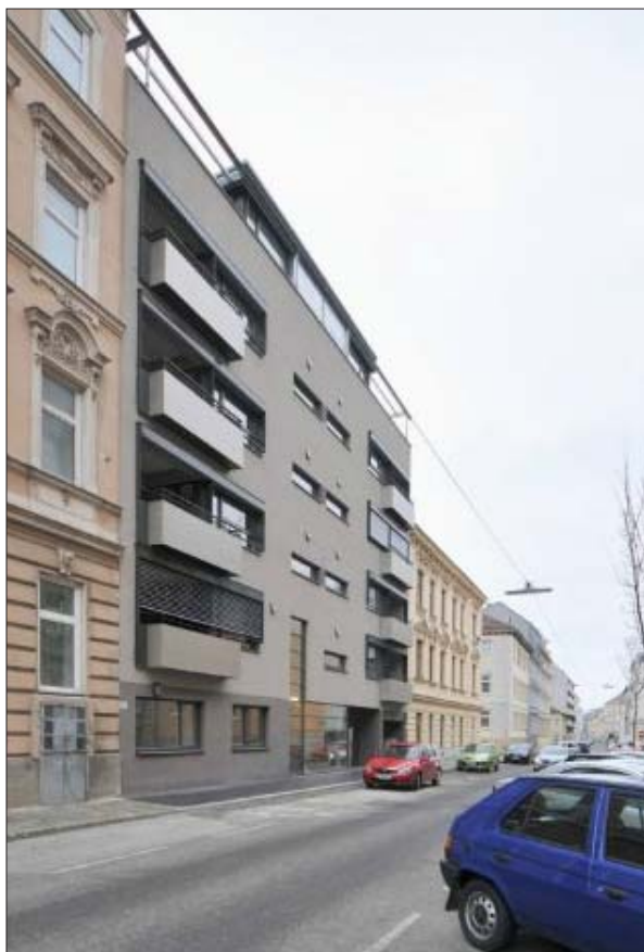
Ansicht Fassade zur Blumengasse
