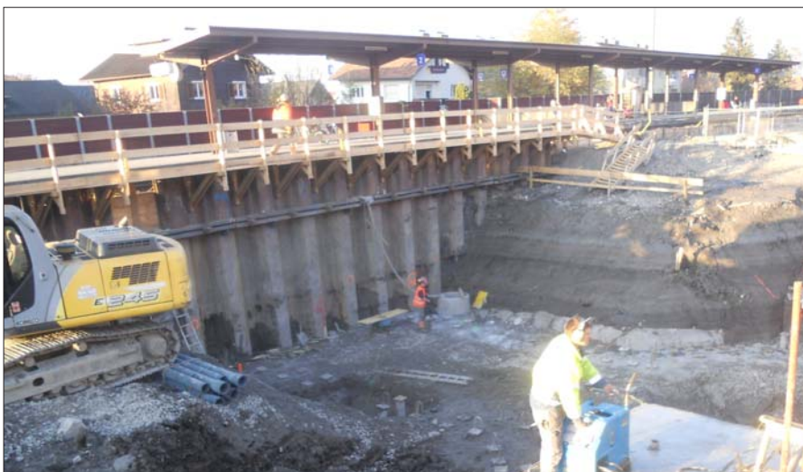
Blick in die Baugrube für die Fußgängerunterführung
