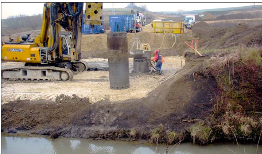
Bohrpfahlarbeiten nächst Oberflächengewässer
