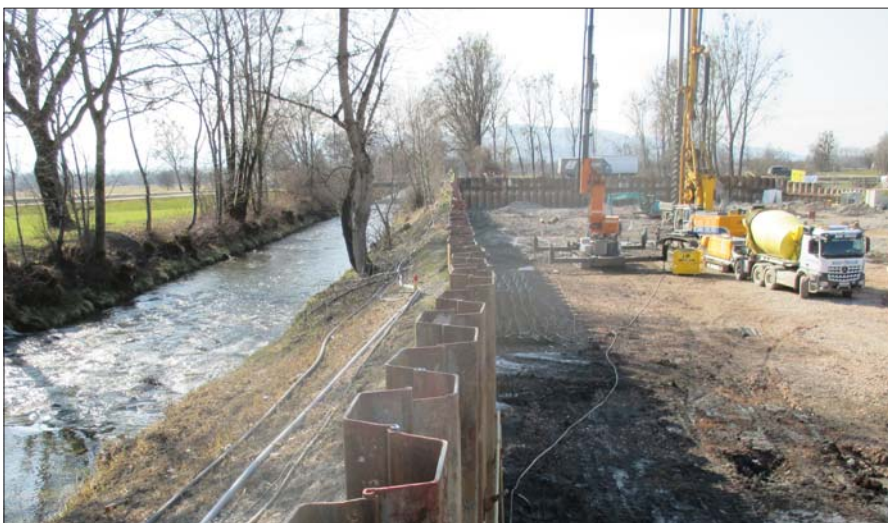
Blick in die Baugrube
