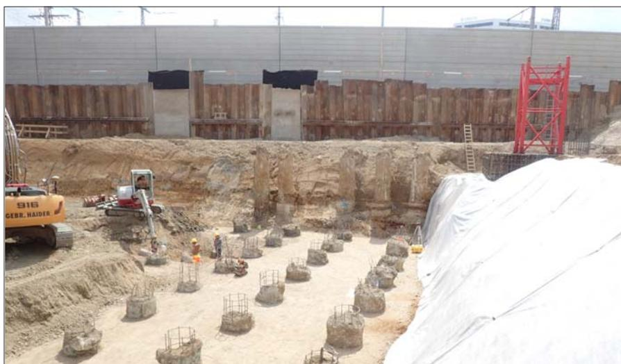
*Blick in die Baugrube mit freigelegten Fundierungspfählen; Im Hintergrund die Stützmauer zu den Bahnanlagen*
