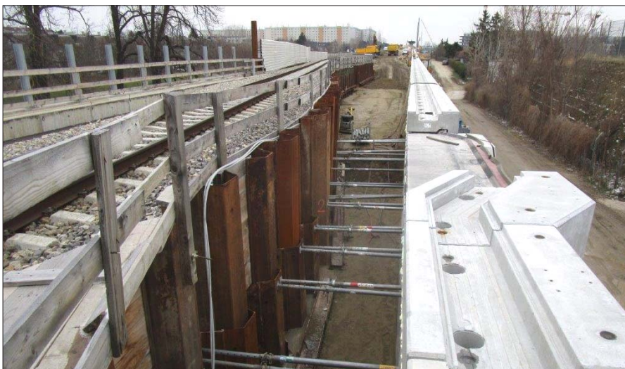
Spundwandsicherung zur Herstellung der Stützmauer zwischen Auparkweg und Hirschstettner Straße
