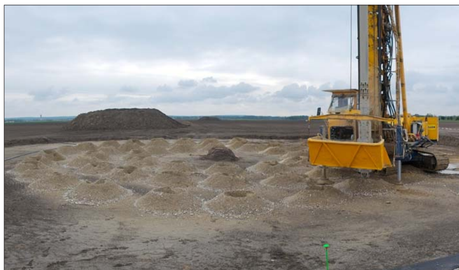
Untergrundverbesserungsarbeiten
