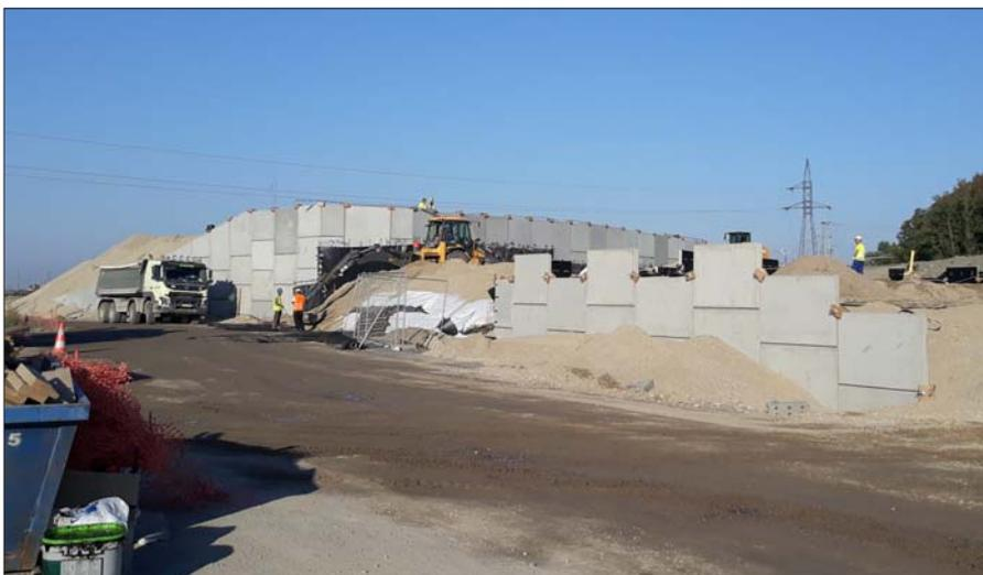
*Herstellung von Brückenwiderlagern aus Bewehrter Erde mit Verblendung aus Betonfertigteilen*
