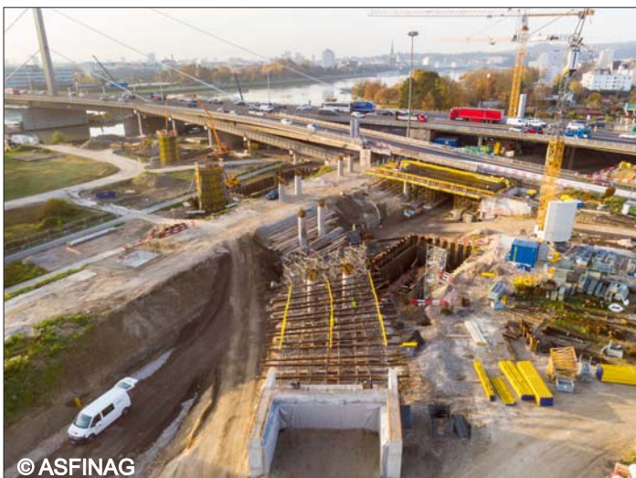
Herstellung der Rampen für die Bypassbrücken über die Donau
