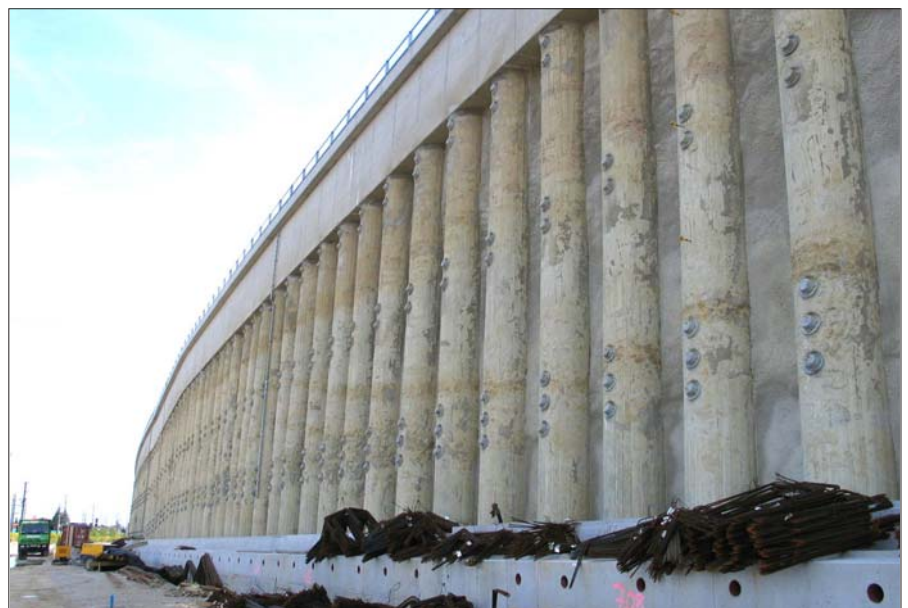
Bohrpfahlwand AL 150 (Blick von Westen)
