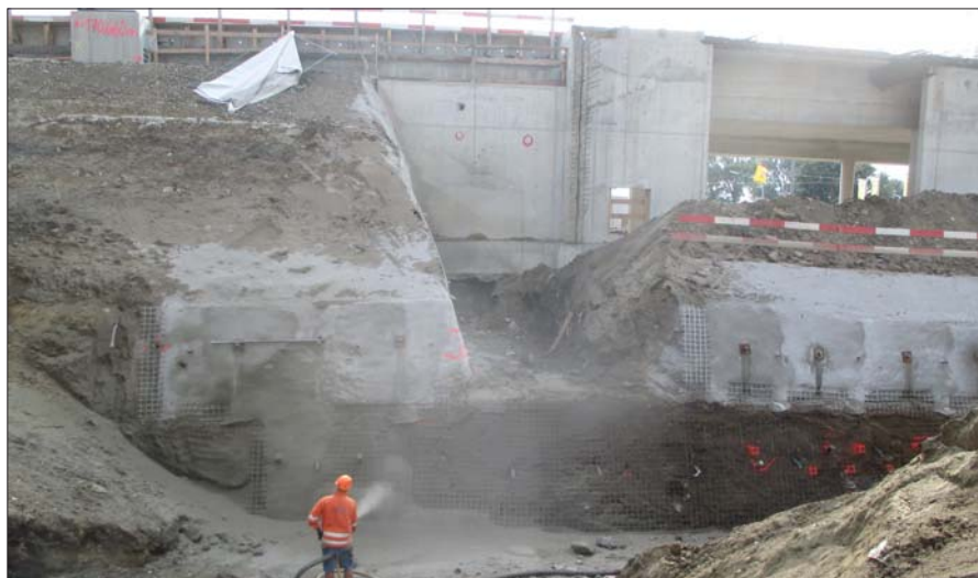
Herstellung der Spritzbetonsicherung oberhalb der Zisterne
